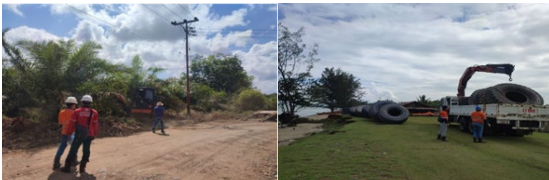
Pembuatan drainase jalan Desa Sumber Jaya dengan menggunakan excavator mini. Construction of road drainage in Sumber Jaya Village using a mini excavator.
