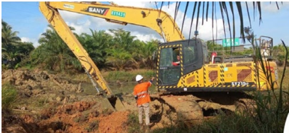
Pembuatan Kolam penampungan air bersih untuk Pondok Pesantren Babussalam Desa Asam Asam
